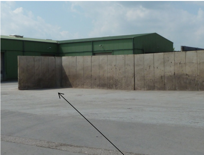
Bild 7: Blick nach Südwesten; Bereich ehemalige oberirdische Dieseltankstelle mit Ölabscheideranlage im Untergrund
