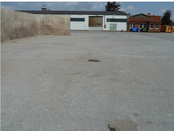
Bild 3: Blick nach Norden (links: Werkstatthalle, rechts: Bürogebäude); im Vordergrund: WHG-Fläche
