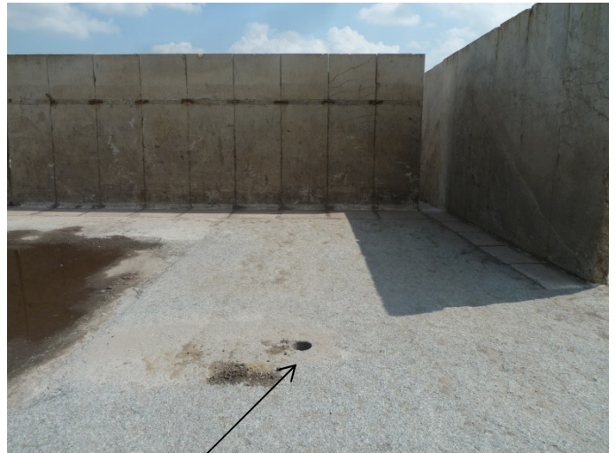
Bild 8: Bohrung RKS 14 im Bereich der ehem. oberirdischen Dieseltankstelle
