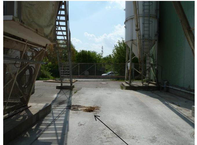
Bild 2: Mischanlage im Südosten neben der Bodenbehandlungshalle; Blick auf Bohrung RKS 6.
