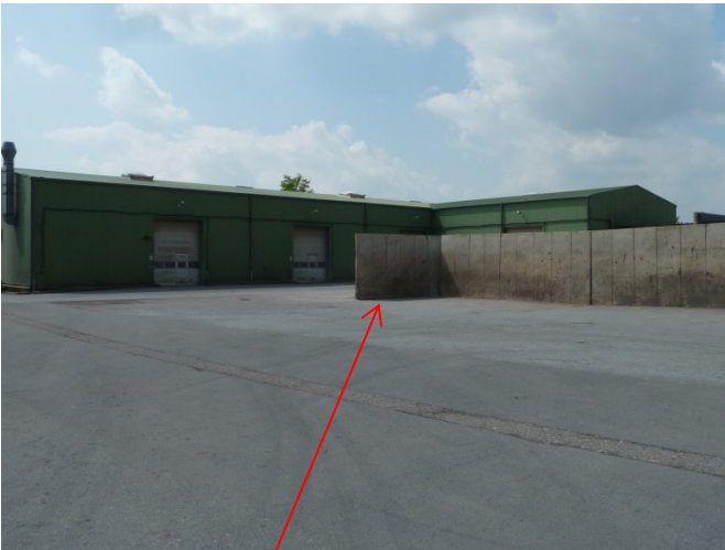
Bild 1: Halle für die mikrobiologische Bodenbehandlung im Südwesten; im Vordergrund: mit Confalt befestigte Lagerfläche (WHG-Fläche) für kontaminierte Materialien
