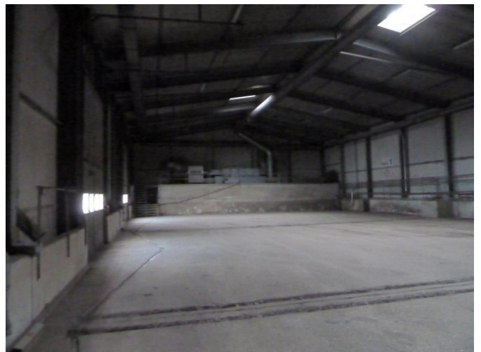
Bild 6: Blick in die Bodenbehandlungshalle
