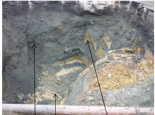
Bild 2: Sanierung mit deutlicher Kennzeichnung des belasteten Materials und des unbelasteten Geschiebelehms
