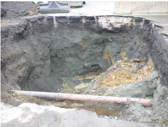
Bild 1: Sanierung des Bereiches „alter Ölabscheider“ mit Blick von Ost nach West
