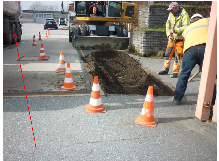
Bild 14: Das Aushubmaterial wurde sofort auf den LKW geladen, Blick von Osten nach Westen
