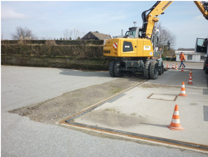
Bild 13: Auffüllung im Bereich der Einfahrt vor Beginn des Aushubs. Entnahmestelle der Probe MP 1 und MP 2 Streifen, Blick von Westen nach Osten
