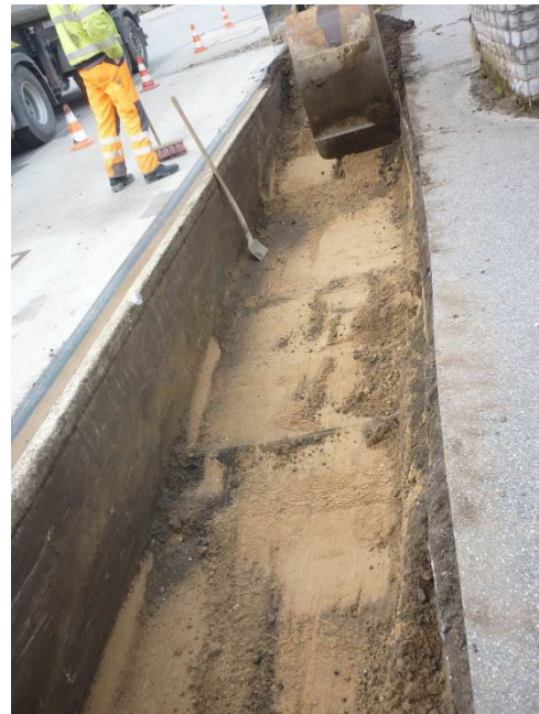
Bild 16: Abgraben der Auffüllung bis zum sauberen Boden (Sand) in ca. 80 cm Tiefe
