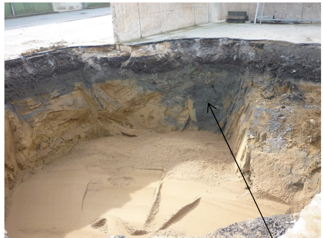
Bild 10: Alter Ölabscheider nach Sanierung mit Sandauffüllung. Blick von Süd nach Nord. (Ansicht alter Rohrgraben im Norden).
