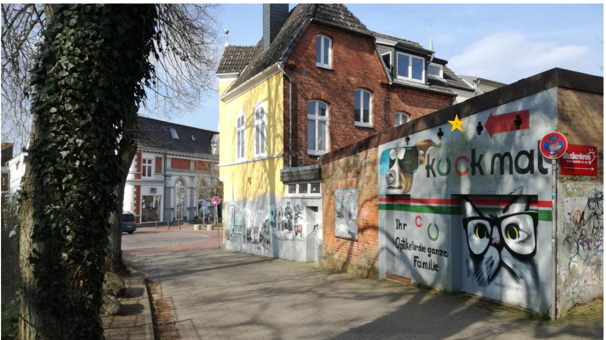
Älteres nicht saniertes Gebäude im Vordergrund mit Öffnungen und Zugänglichkeit zum Innenraum, Möglichkeit für Habitate von Fledermäusen oder Nischenbrütern ★
