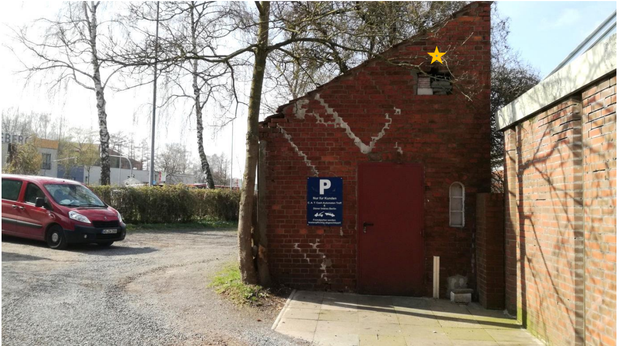
Kleineres Nebengebäude im Süden mit Öffnungen zum Innenraum/Dachbereich ★
