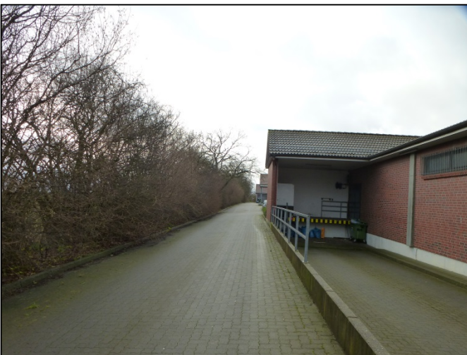
Abb. 4: Gebäuderückseite des ALDI-Marktes mit Anlieferzone und östlichem Randknick. Auch hier sind zahlreiche geeignete Strukturen für die Anlage von Fledermausquartieren in den Dachbereichen vorhanden
