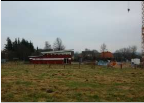
Blick über das Grünland nach Osten auf Bewegungshalle und Baustelle
