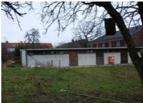
Gebäude im Nordosten
