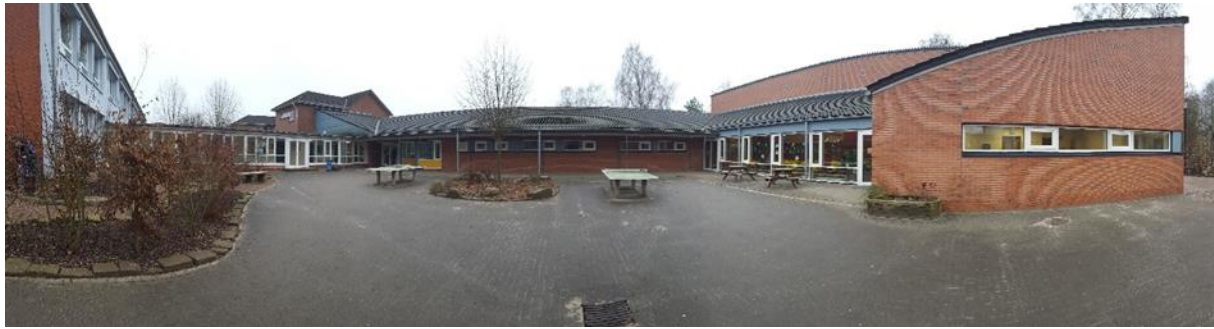
Abbildung 24: Hauptgebäude und Mensa: Ansicht Haupteingang
