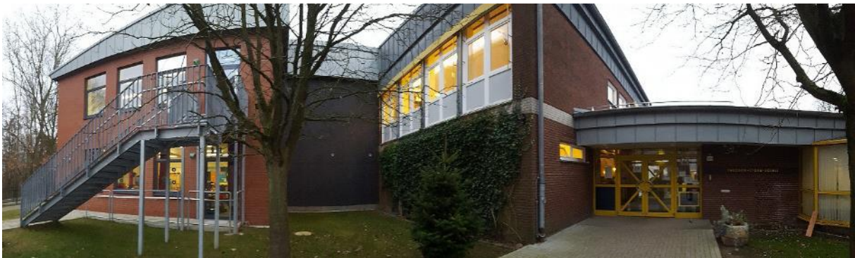
Abbildung 12: Hauptgebäude und Mensa: Ansicht Haupteingang
