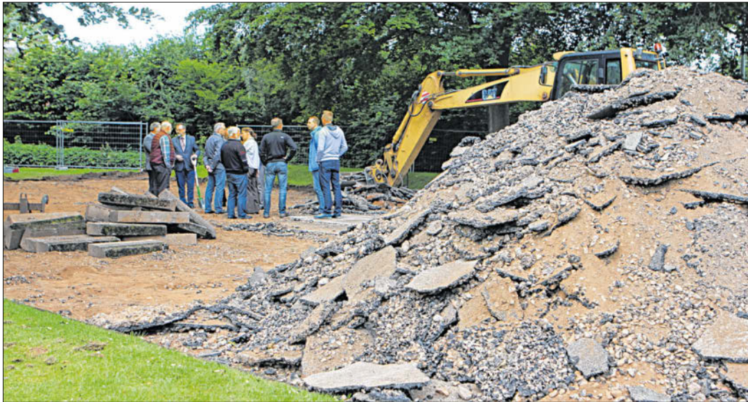
Der Belag des Basketballplatzes, der früher sogar als Rollschuhbahn genutzt wurde, ist bereits entfernt worden. Der Platz erhält einen neuen Belag, der multifunktionell genutzt werden kann.
