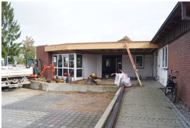
Familienzentrum Südstadt im Bau
