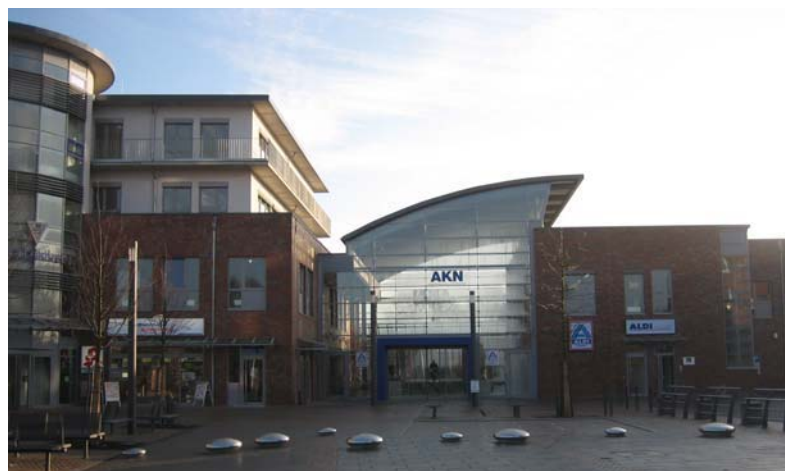
Praxisbeispiel: Neubau eines Bahnhofsgebäudes in Quickborn
