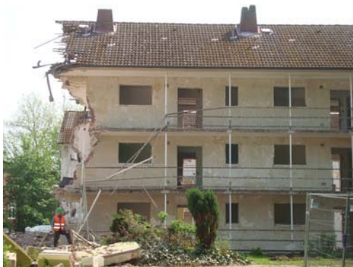
Rückbau nicht mehr zeitgemäßer Wohnungen in der Stadt Wedel
